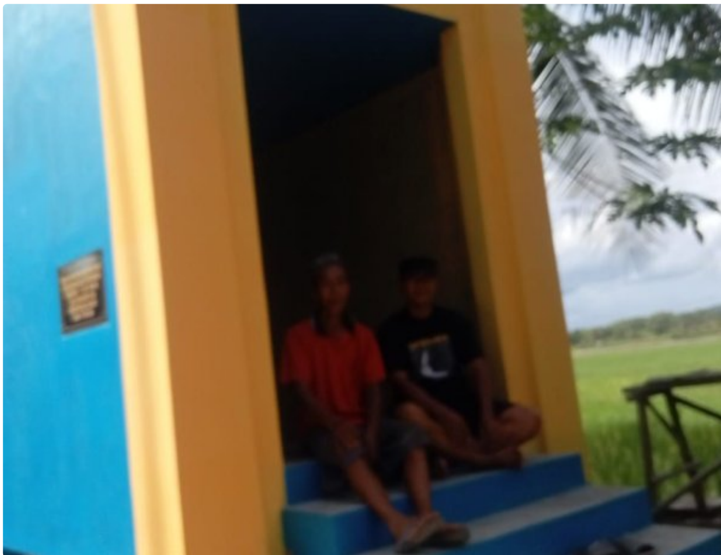
Pembangunan Irigasi Perpompaan di Desa Binangun
